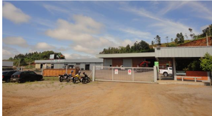
Figura 8 – Fachada da empresa RPmetal
