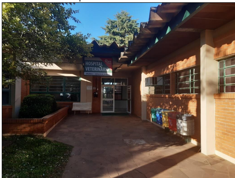
Figura 1 - Fachada do Hospital Veterinário da Universidade de Passo Fundo
