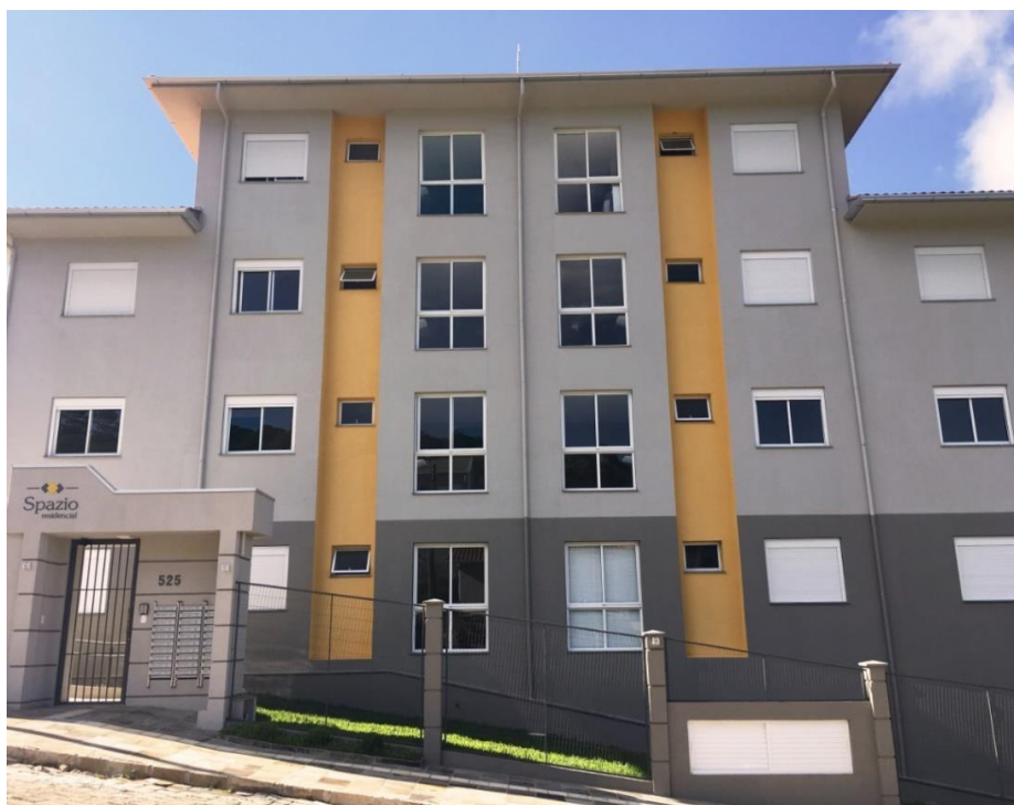
Figura 4 - Fachada do Edifício Spazio Residencial
