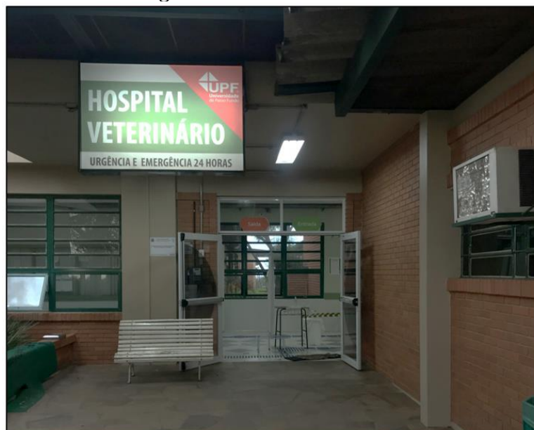
Figura 8 – Fachada do HV-UPF.
