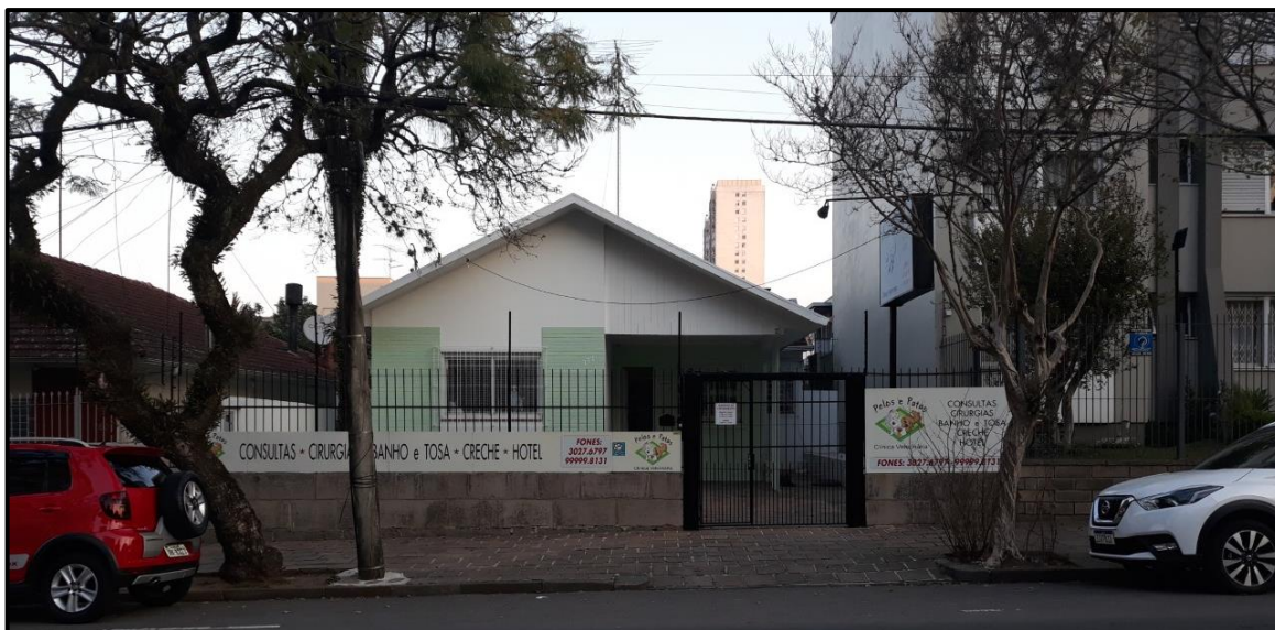
Figura 7 – Fachada da Clínica Veterinária Pelos e Patas.
