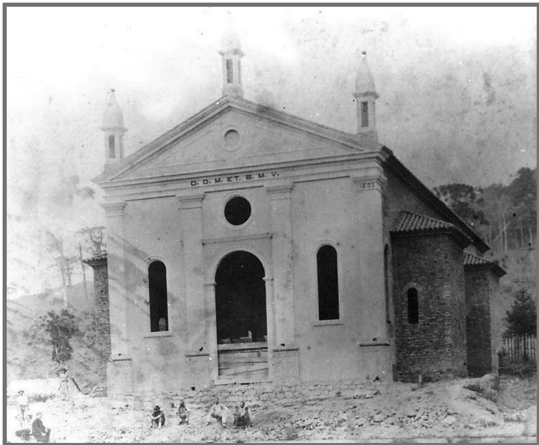
Figura 5 - Construção da Igreja [ca. 1895]
