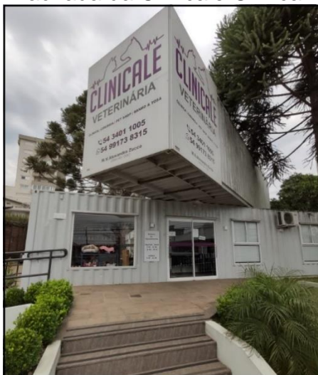
Figura 6 - Fachada da Clinicale Clínica Veterinária
