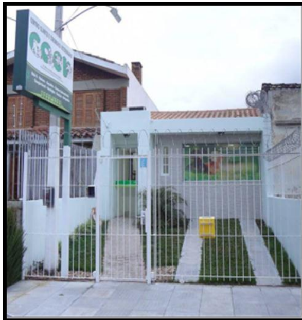
Figura 1 -Fachada do Centro Clínico e Cirúrgico Veterinário CCCV, Pelotas, RS.
