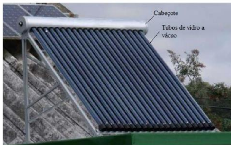
Figura 7 - Coletor solar de tubos de vidro a vácuo
