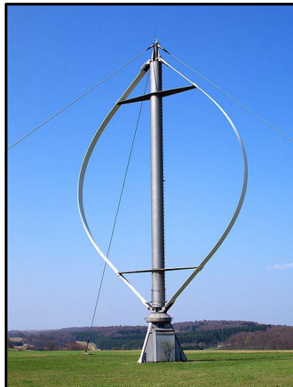
Figura 8 – Turbina Darrieus de lâmina curva
