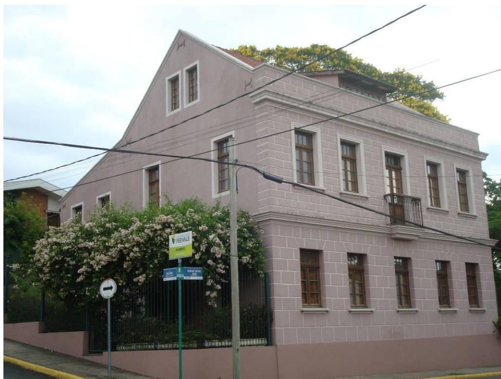
Figura 19: Construção em Hamburgo Velho – Novo Hamburgo Fonte: A autora, 2011
