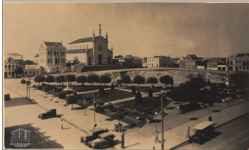
Figura 9 - Praça Dante Alighieri em obras. 29
