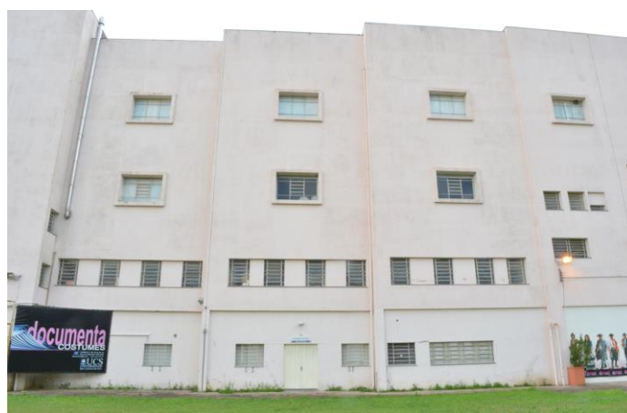
Figura 18 - Parede externa lateral esquerda do auditório do Campus 8.
