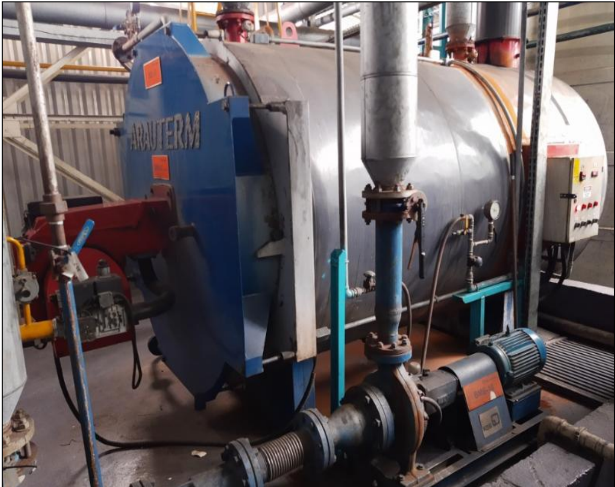
Figura 21 - Caldeira fumotubular CAD – HP 1500 Arauterm
