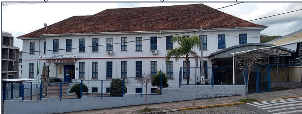
Figura 13 – Fachada atual do Colégio Nossa Senhora Aparecida
