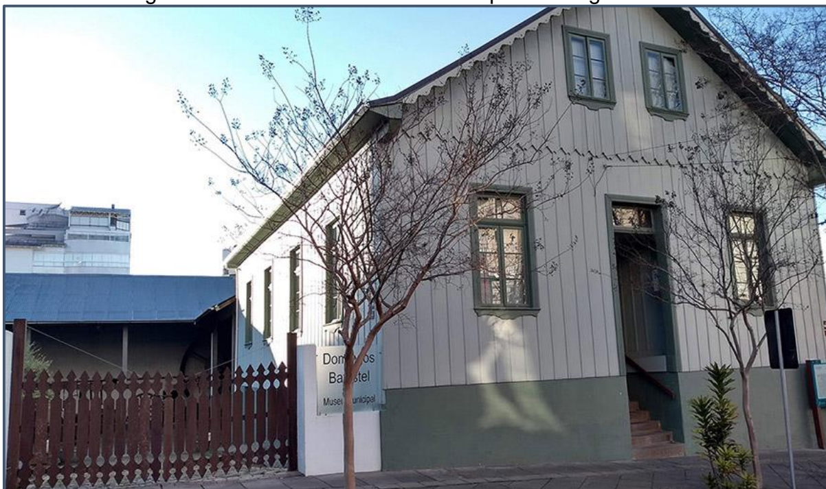
Figura 4 – Fachada do Museu Municipal Domingos Battistel
