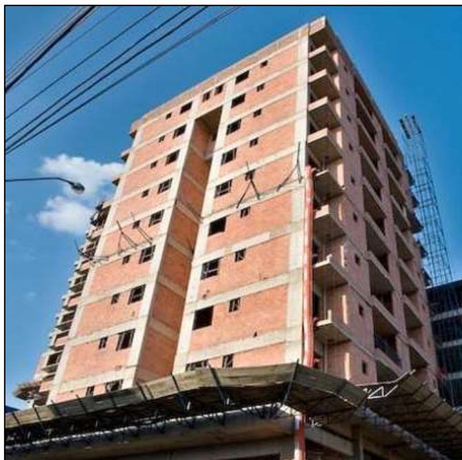
Figura 1 - Sistema construtivo convencional em C.A.
