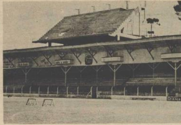
As obras já iniciadas e bastante adiantadas do novo estádio.
