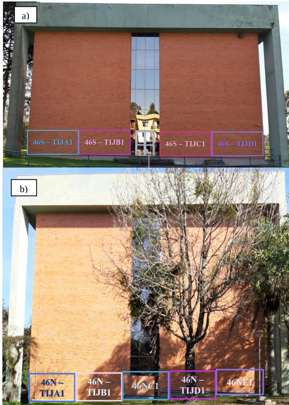
Figura 22 - Nomenclatura das áreas de fachada de tijolo aparente do Bloco 46 a) ao sul b) ao norte
