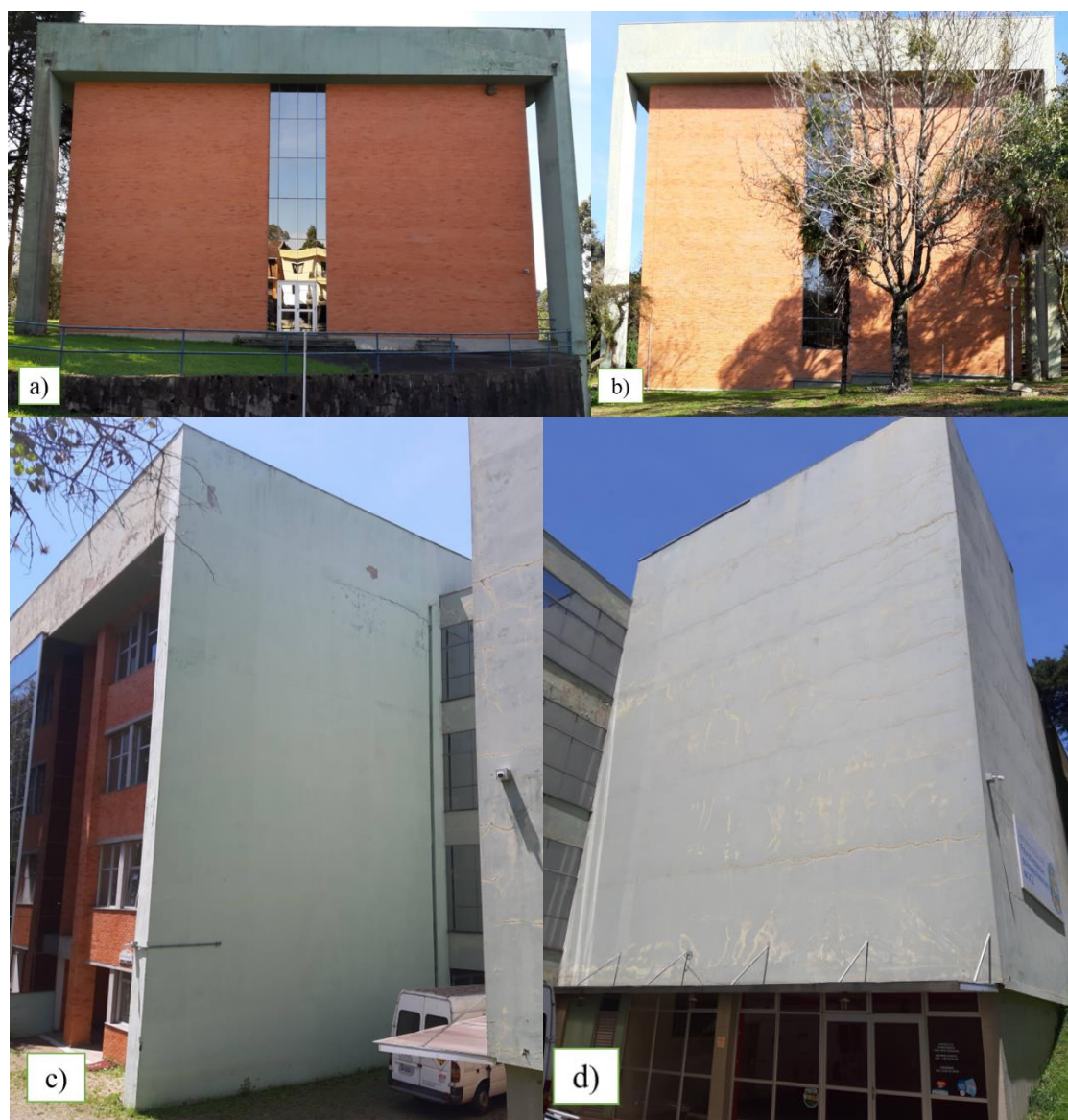
Figura 17 - Fachadas do Bloco 46: a) Tijolo aparente (sul) b) Tijolo aparente (norte) c) Revestimento de argamassa (sul) d) Revestimento de argamassa (norte)
