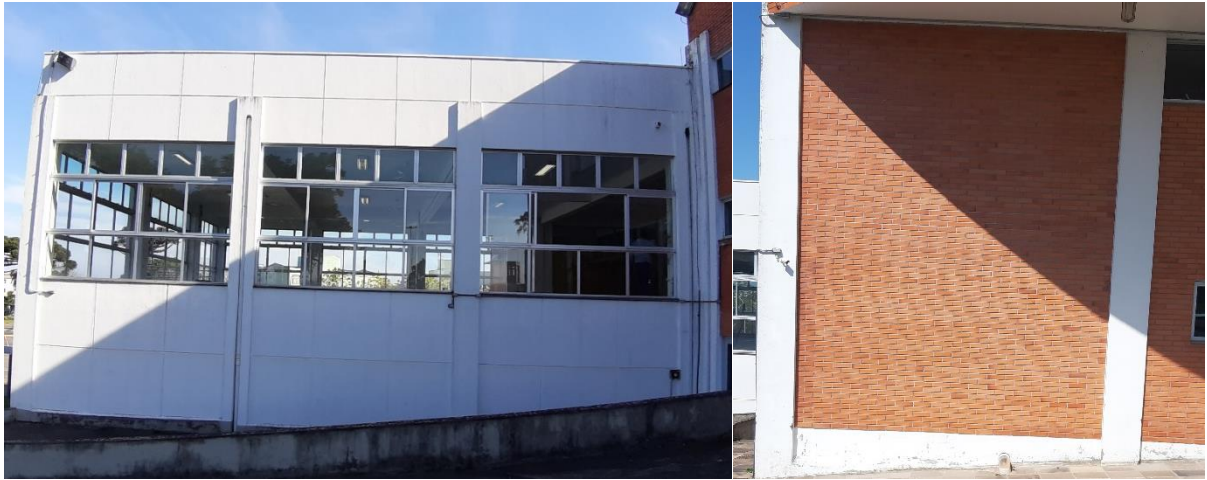
Figura 15 - Fachadas Norte do restaurante universitário: a) revestimento de argamassa b) tijolo aparente
