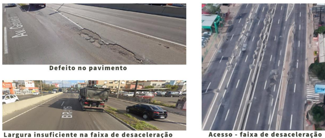
Figura 8 - Ponto 900 metros do km 264 da BR-116
