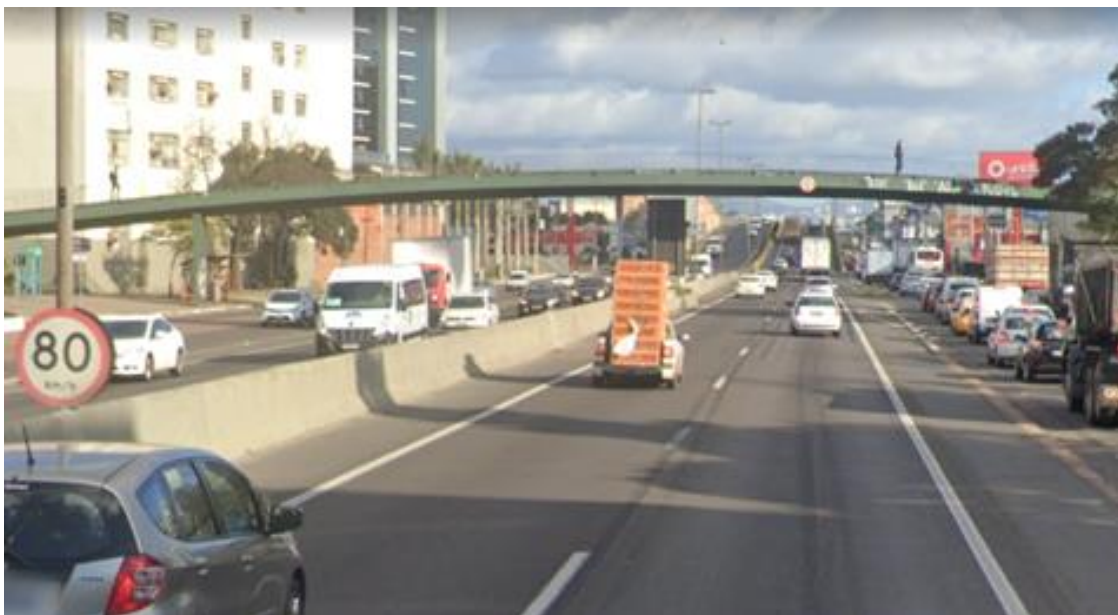
Figura 7 - Ponto 500 metros do km 265 da BR-116
