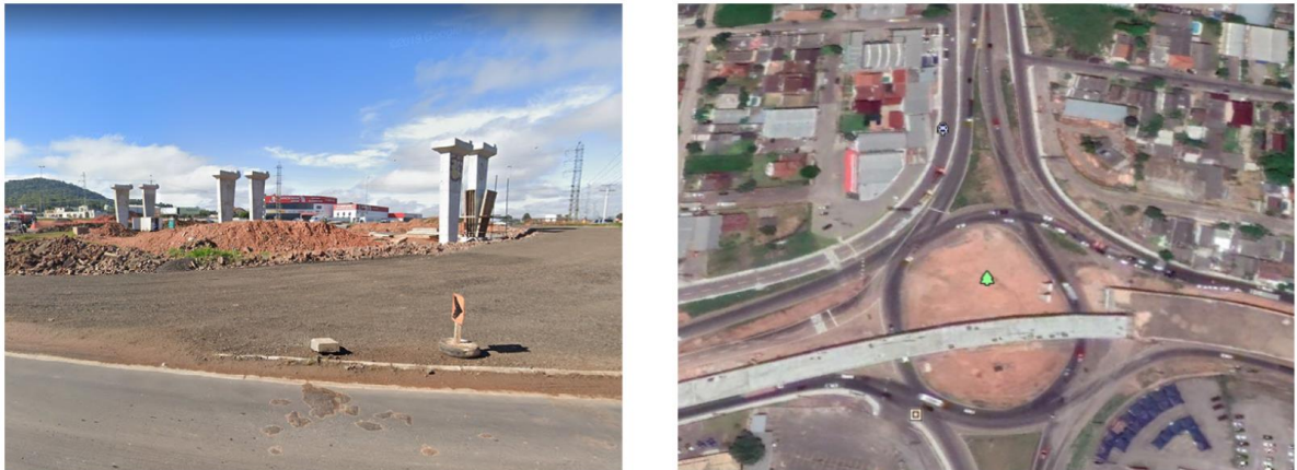
Figura 10 - Obra do viaduto da BR-158
