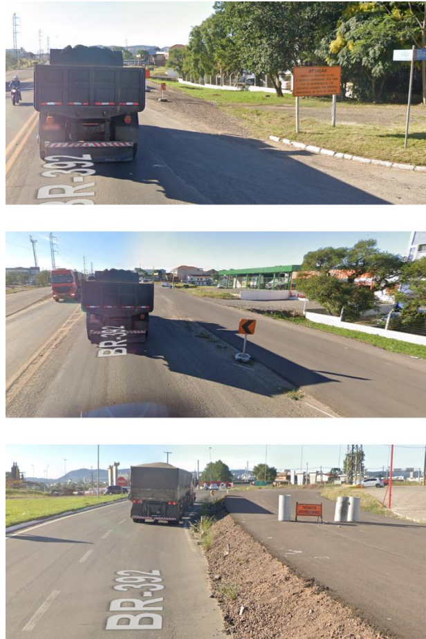
Figura 11 - Sinalização utilizada para alerta das obras
