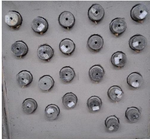
Figura 21: Arranjo da furação e pastilhas coladas
