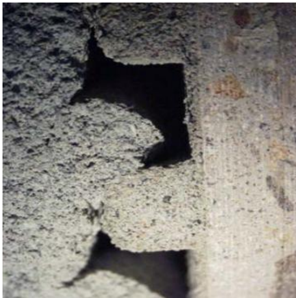
Figura 11: Interface concreto / chapisco desempenado / argamassa.
