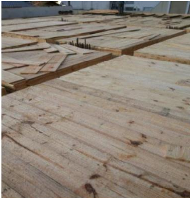
Figura 5: Assoalho com tábua serrada.
