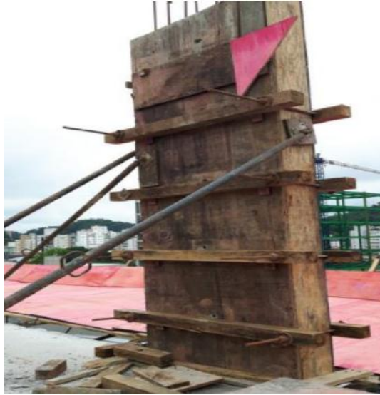
Figura 6: Fôrma de pilar.
