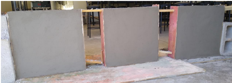
Figura 19: Minis paredes com o revestimento argamassado
