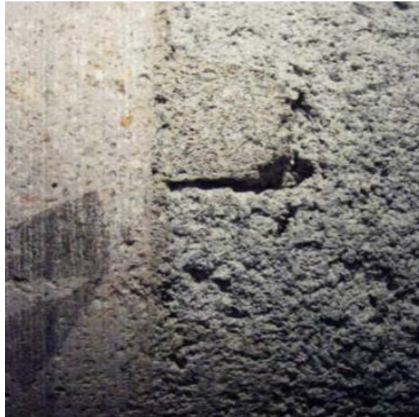
Figura 10: Interface concreto / chapisco projetado manualmente / argamassa.
