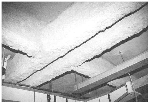
Figura 13 - Aparência da argamassa projeta após sua aplicação
