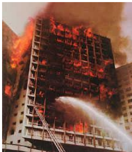
Figura 5 - Foto do incêndio no Edifício Andraus (SP)
