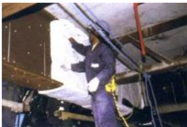
Figura 18 - Colocação da manta de lã de rocha
