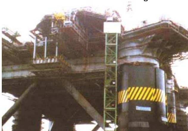
Figura 14 - Plataforma P-19 Petrobrás com argamassa de vermiculita
