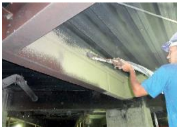
Figura 12 - Aplicação de argamassa projetada
