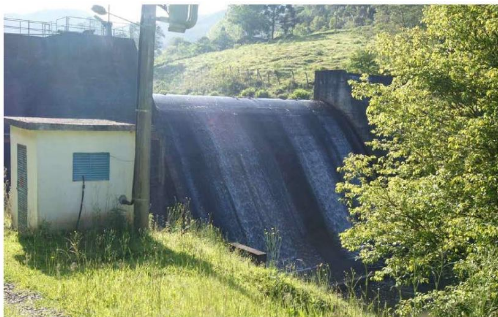
Figura 16 - Barragem Santa Isabel
