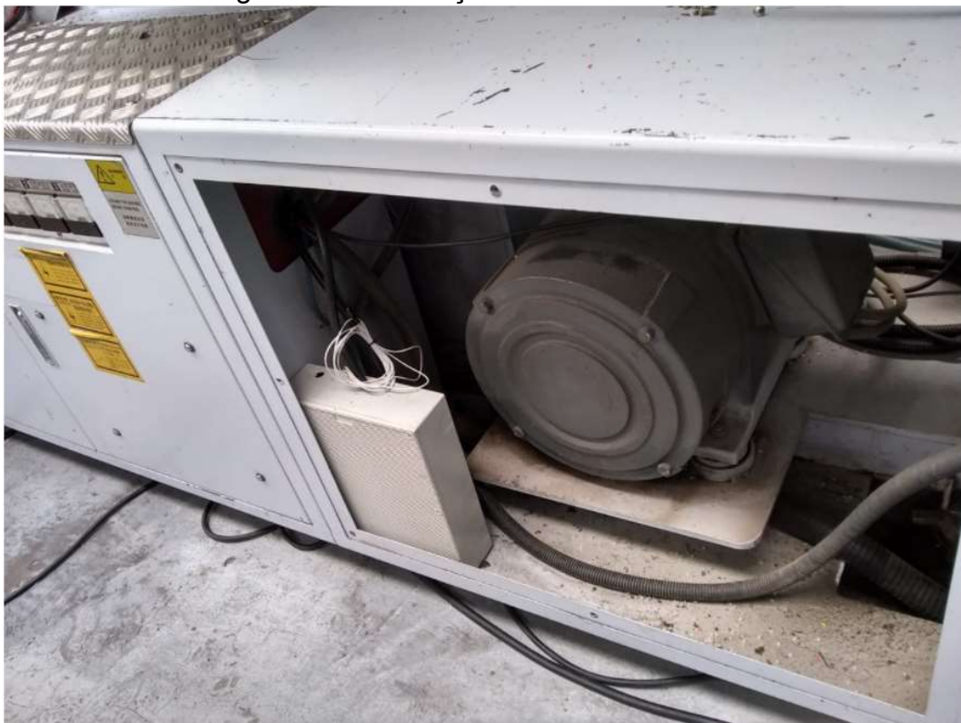
Figura 56 – Instalação da CPU do sistema
