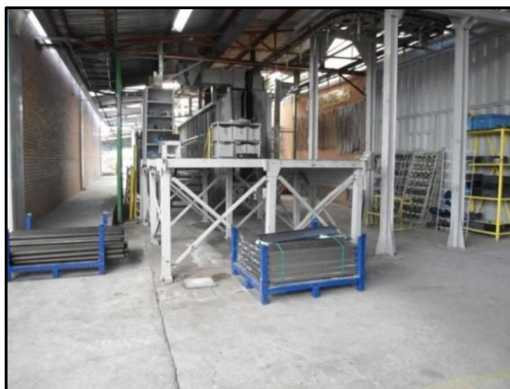
Figura 47 - Plataforma prévia aos banhos na situação inicial
