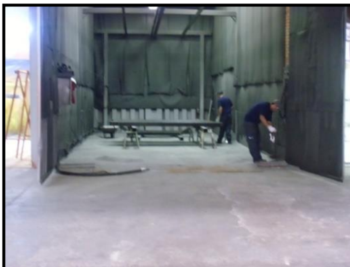
Figura 54 – Cabine do jato mal iluminada.
