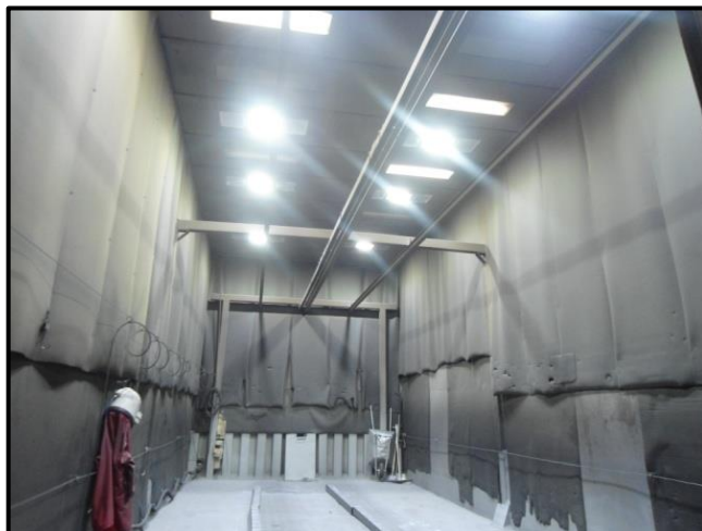
Figura 56 – Cabine do jato de granalha de aço após a instalação dos LEDS
