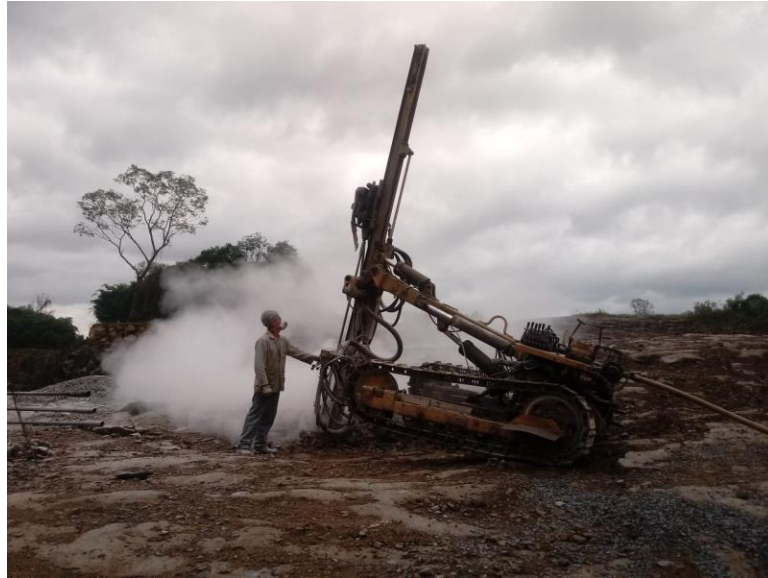
Figura 1 - Início da perfuração da Rocha com a Carreta de Perfuração
