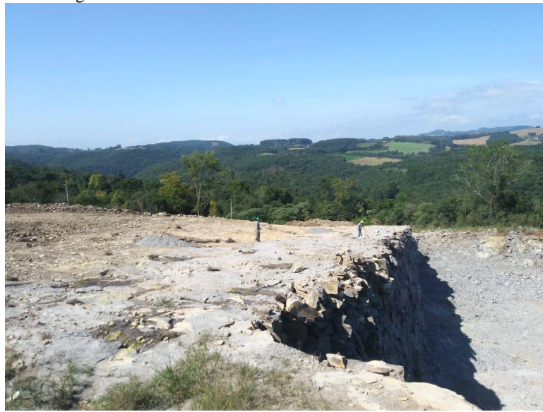
Figura 2 - Foto da Bancada antes do desmonte de Rocha.
