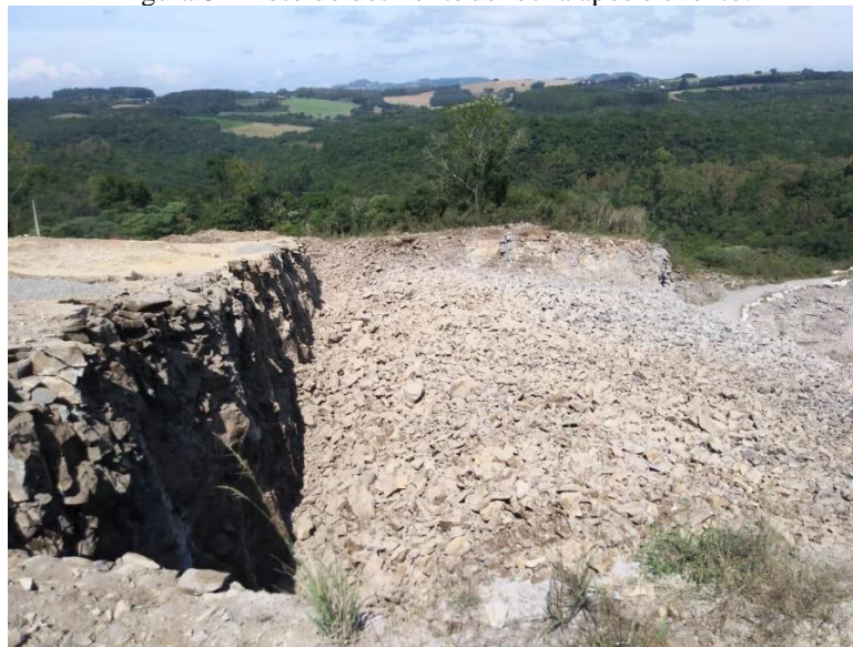
Figura 3 - Foto do desmonte de rocha após o evento.
