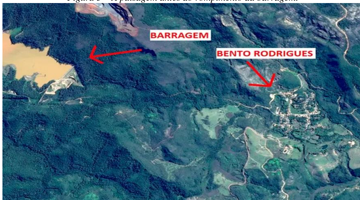
Figura 5 – A paisagem antes do rompimento da barragem.
