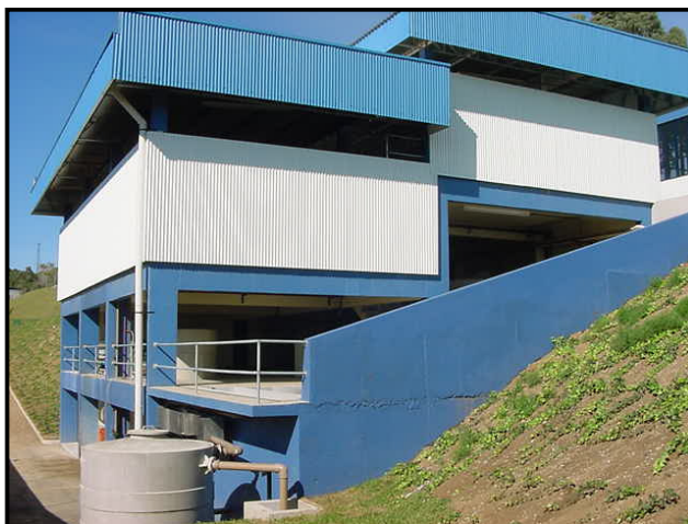
Figura 1. Vista parcial da estação de tratamento de efluentes da Empresa Tramontina Farroupilha S. A. Indústria Metalúrgica.
