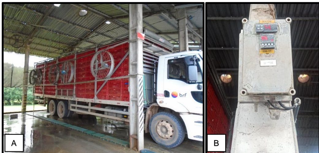
Figura 15 - Controle de temperatura na área de recepção. A) Ventiladores e aspersores de água. B) Aparelho termo-higrômetro.
