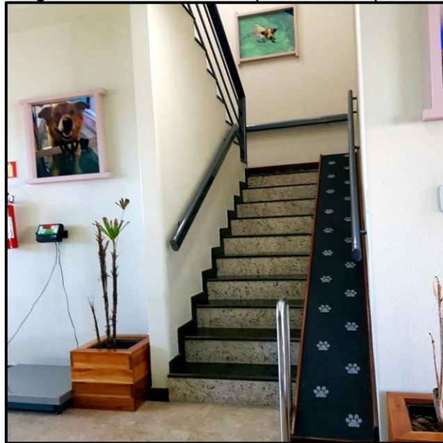
Figura 4 - Escada e rampa antiderrapante.
