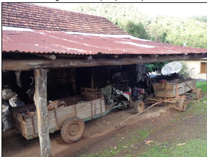
Figura 11 - Galpão para depósito
