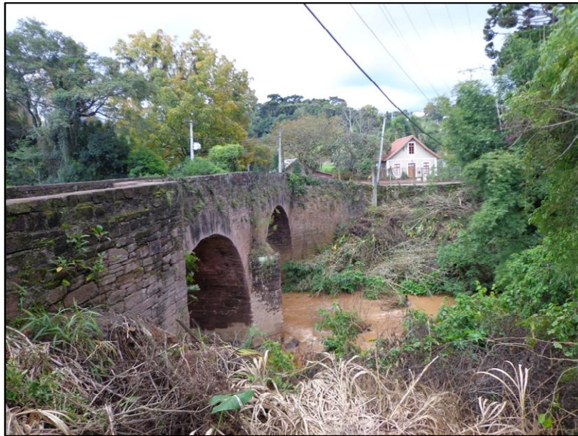
Figura 36 - Ponte de Pedra
