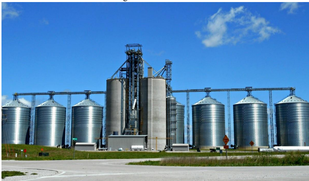
Figura 1 - Estrutura de silos
