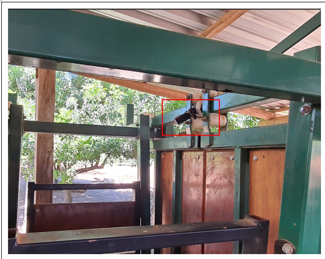
Figura 4 – Suporte de fixação da câmera, destacado em vermelho, sobre a porta de saída do brete
