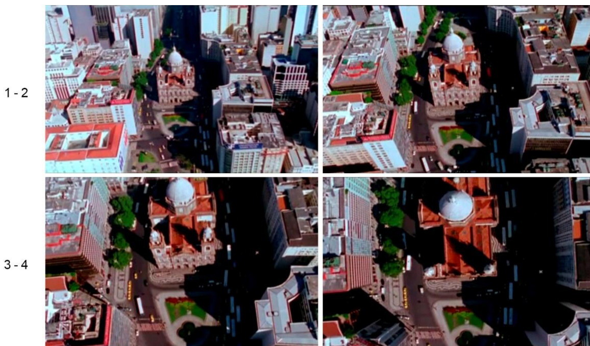
Figura 2 - Igreja de Nossa Senhora da Candelária vista de cima
