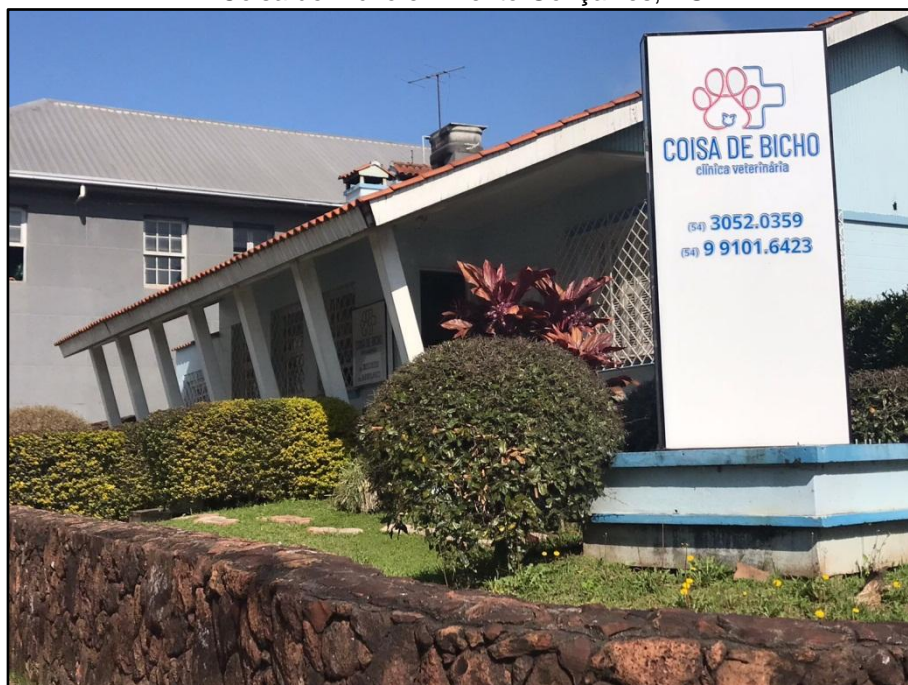
Figura 1 - Apresentação do local de estágio curricular obrigatório, fachada da Clínica Veterinária Coisa de Bicho em Bento Gonçalves, RS
