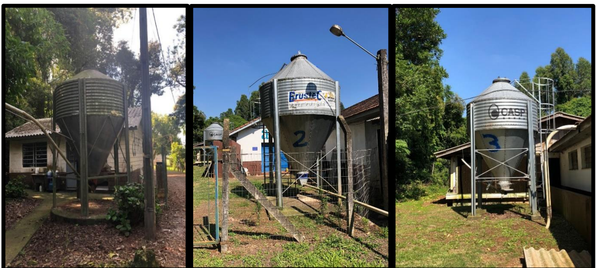
Figura 3 – Silos de ração
