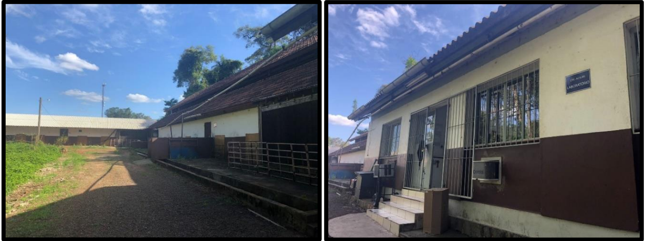
Figura 2 – Galpão 1 e 2 junto ao laboratório da CPS
