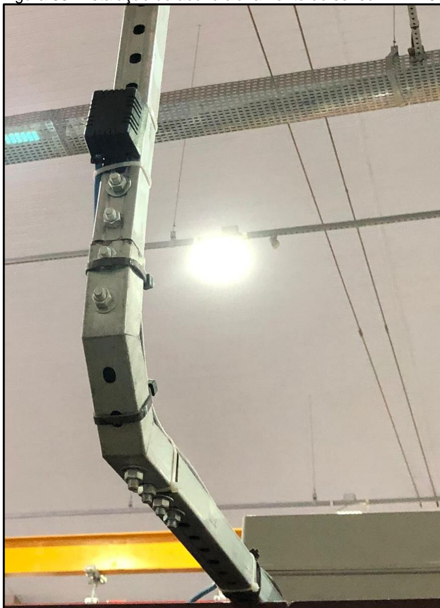
Figura 66: Instalação do acondicionamento do sensor BME280
