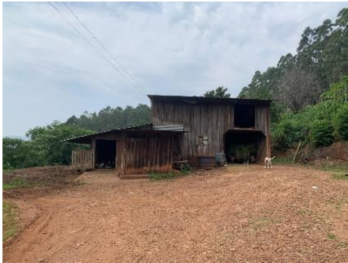
Figura 2 – Galpão da propriedade
