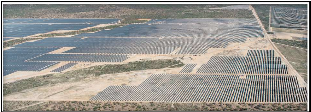
Figura 31 - Usina Solar Fotovoltaica UFV Juazeiro V
