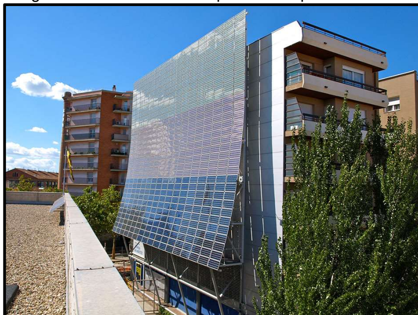
Figura 34 - Fachada de um prédio com painéis solares
