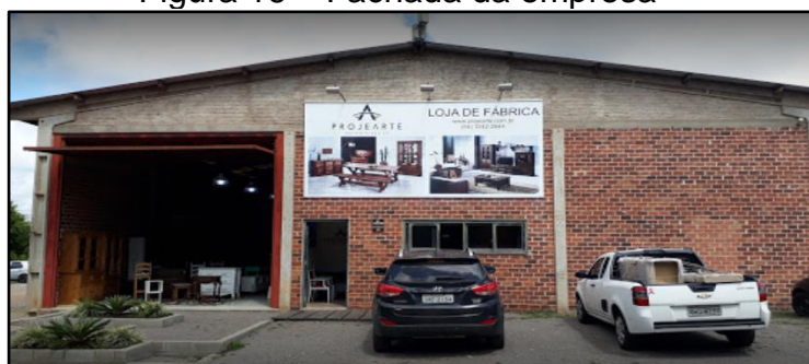
Figura 16 – Fachada da empresa
