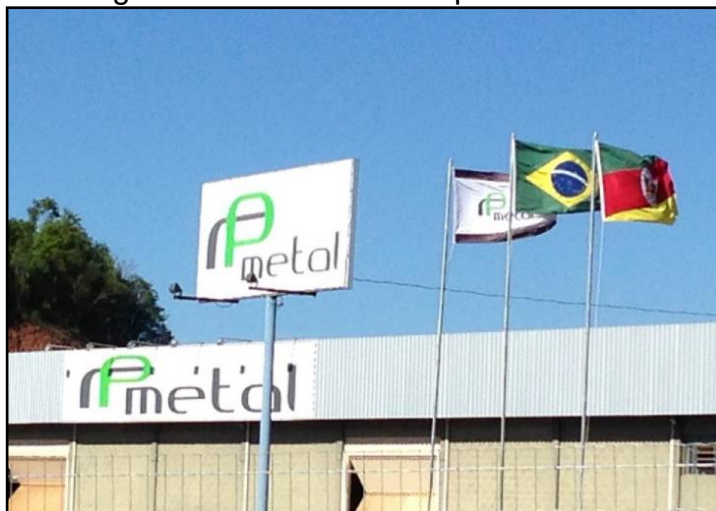
Figura 6 - Fachada da empresa
