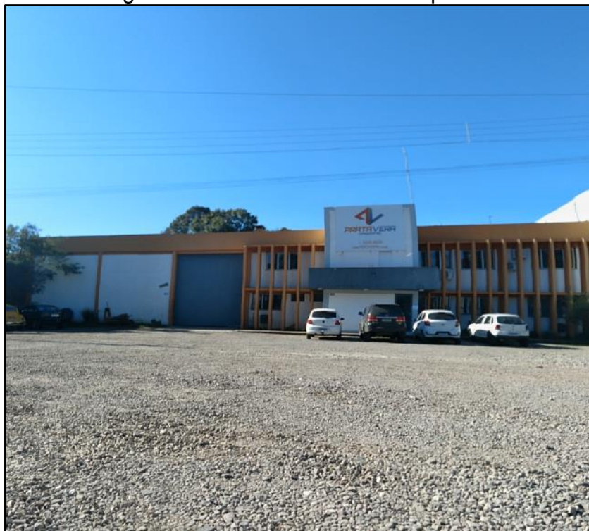
Figura 11 - Fachada atual da empresa
