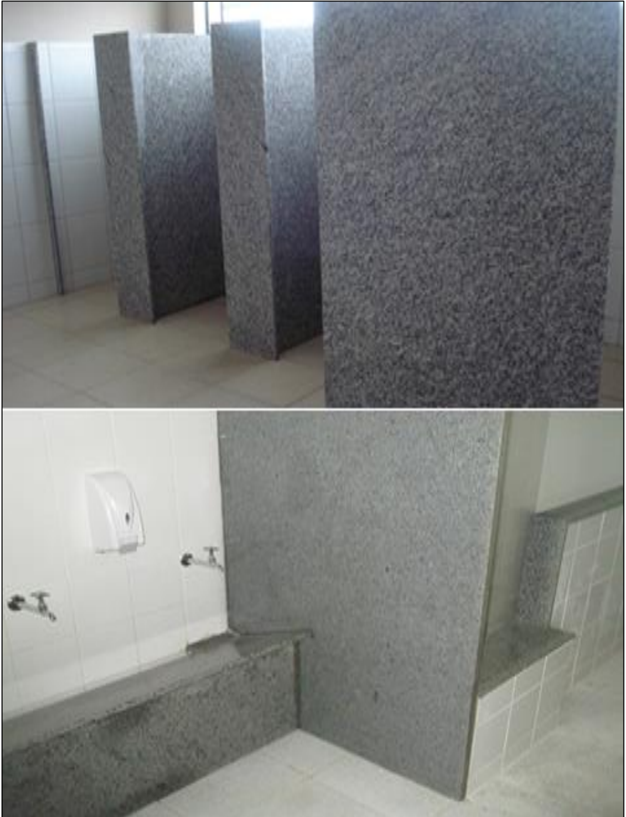
Figura 8 – Exemplo de divisórias de banheiro
