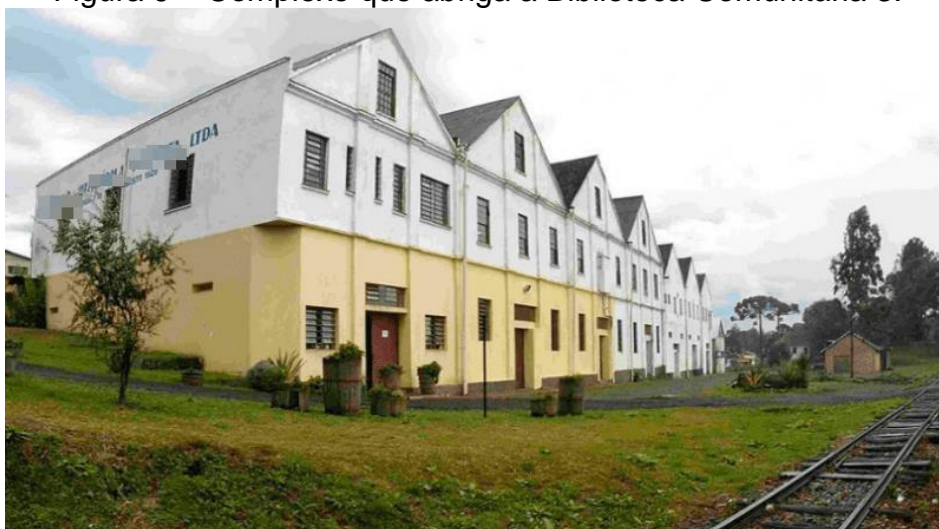
Figura 9 – Complexo que abriga a Biblioteca Comunitária 3.
