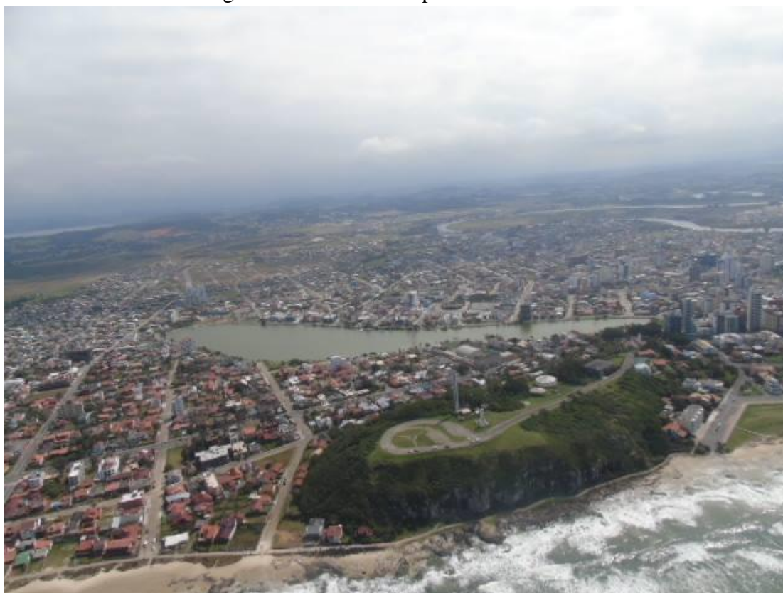
Figura 18 – Vista aérea parcial de Torres/RS
